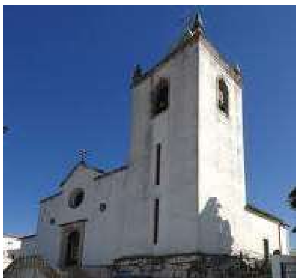
Figura 21 - Igreja de Santa Eufémia (exterior)
