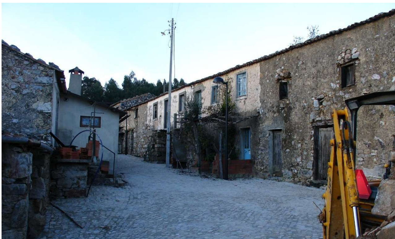
Figura 31 - Aspeto de arruamento durante a execução das obras
