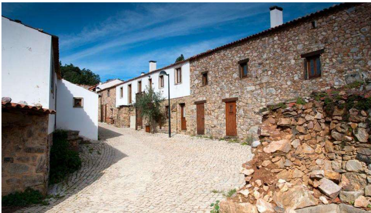
Figura 32 - Arruamento após a execução das obras
